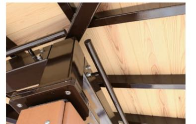
側面膜取付用のパイプフレーム
