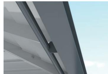
側面膜取付用のパイプフレーム
