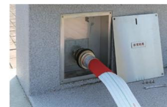
ボックス内には、断水時に給水用ホースを接続する接手（継ぎ手）が組み込まれています。本体には常用と非常時用の2系統の給水管を併設しています。ボックスは南京錠で管理いただく仕様になっています。
