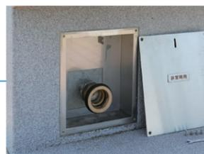
断水時にはこの接手（継ぎ手）に給水用ホースを接続します。
