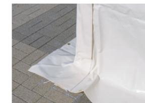
防災四阿で使用の際のテント生地は、高い耐水・耐候性を持った、国土交通大臣認定膜材（防災2級合格品）となっています。防災パーゴラのテントで使用されることが多い「ターポリン」と比較して引張強度に優れ、破損しにくい安心仕様となっています。
