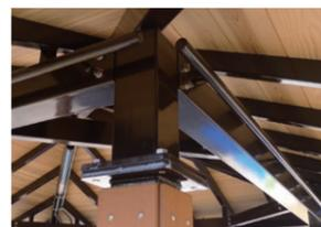
柱、小屋組といった構造材を鋼製とすることで、高い耐久性と強度を保持し、製品の長寿命化につなげています。
